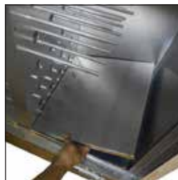
A3. Verkleidung aus Aluminiumpanel entfernen.
