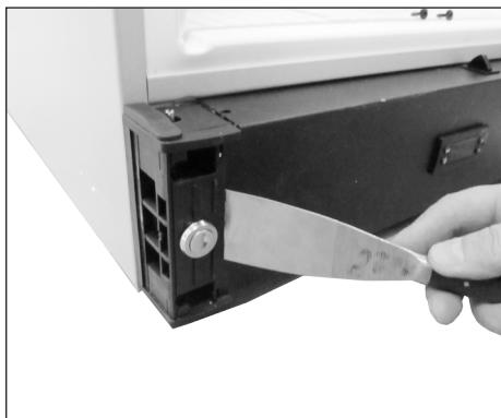
4. Fodpanelet løsnes ved hjælp af et egnet værktøj.
