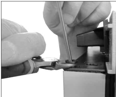
7. Buchse und Türschließer mithilfe einer Zange entfernen.
