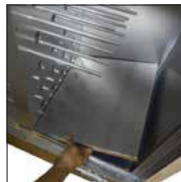
A3. Verkleidung aus Aluminiumpanel entfernen.
